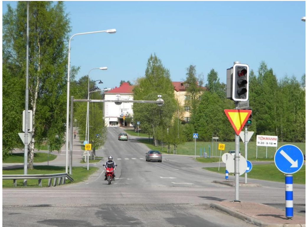
Kuva: Pohjanmaantien (kt 44) eli Laviantien ja Tapalankadun risteyksestä.
