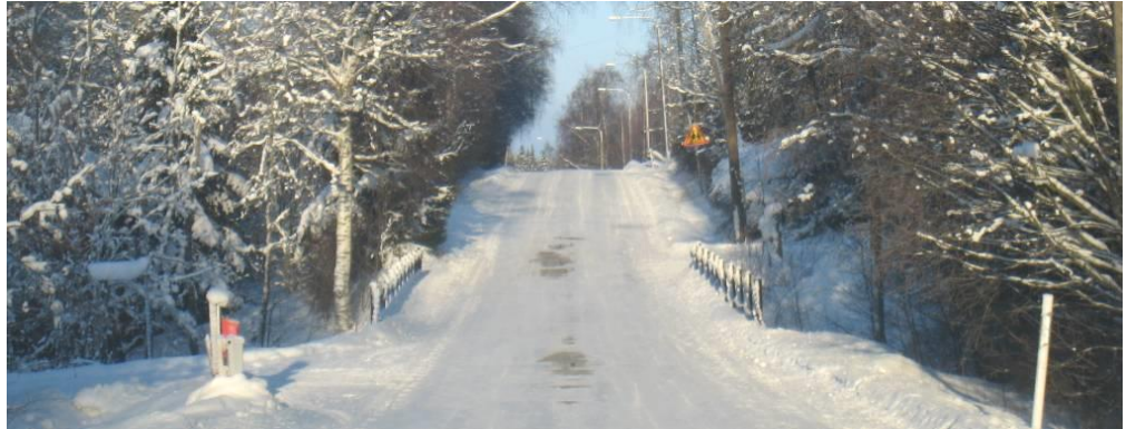
Kuva: Lohikonttiellä sijaitseva Narilan silta vie Lohipuron yli.
