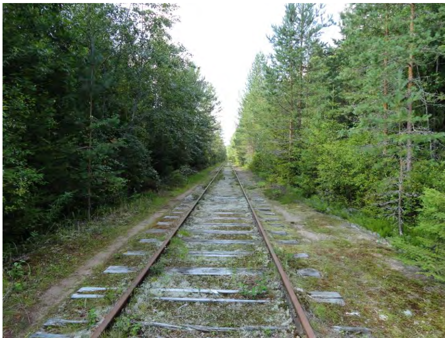
Kuva 6 Käytöstä poistettu rata.
