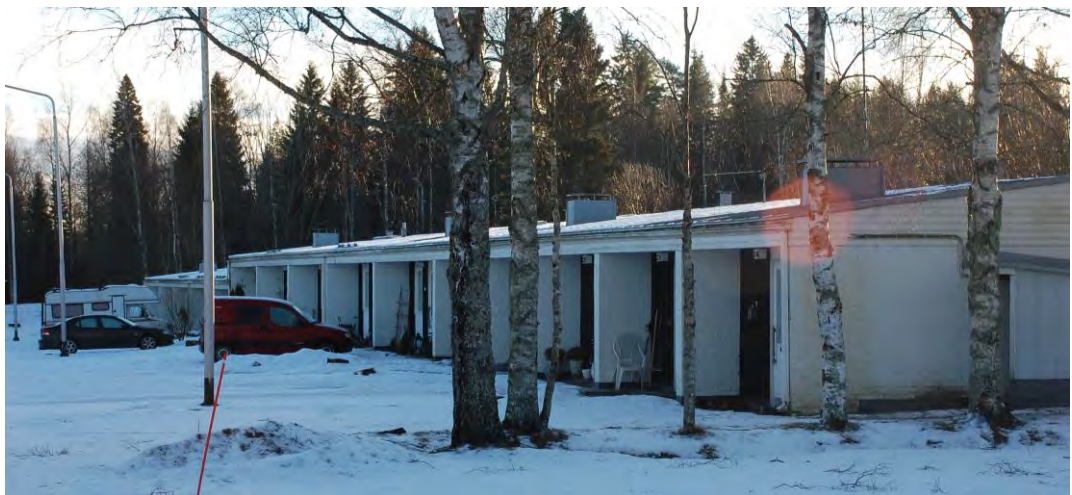
Tupavainion alueen rivitalo, mikä sijaitsee Väinämöisenkadun vieressä.
