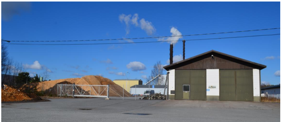
Kuva 5. Näkymä Savikadulta kaukolämpölaitoksen suuntaan.
