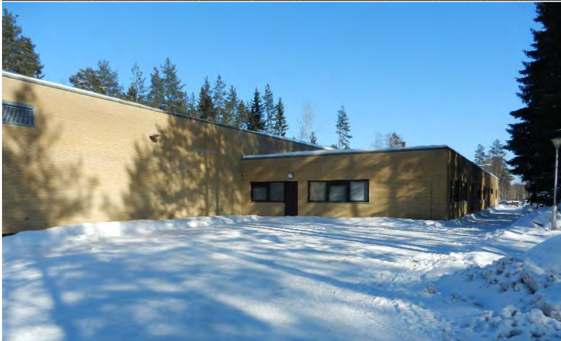
Kuva 20. Medipiste Oy:n jalkinevarasto/konttori pihasta kuvattuna.
