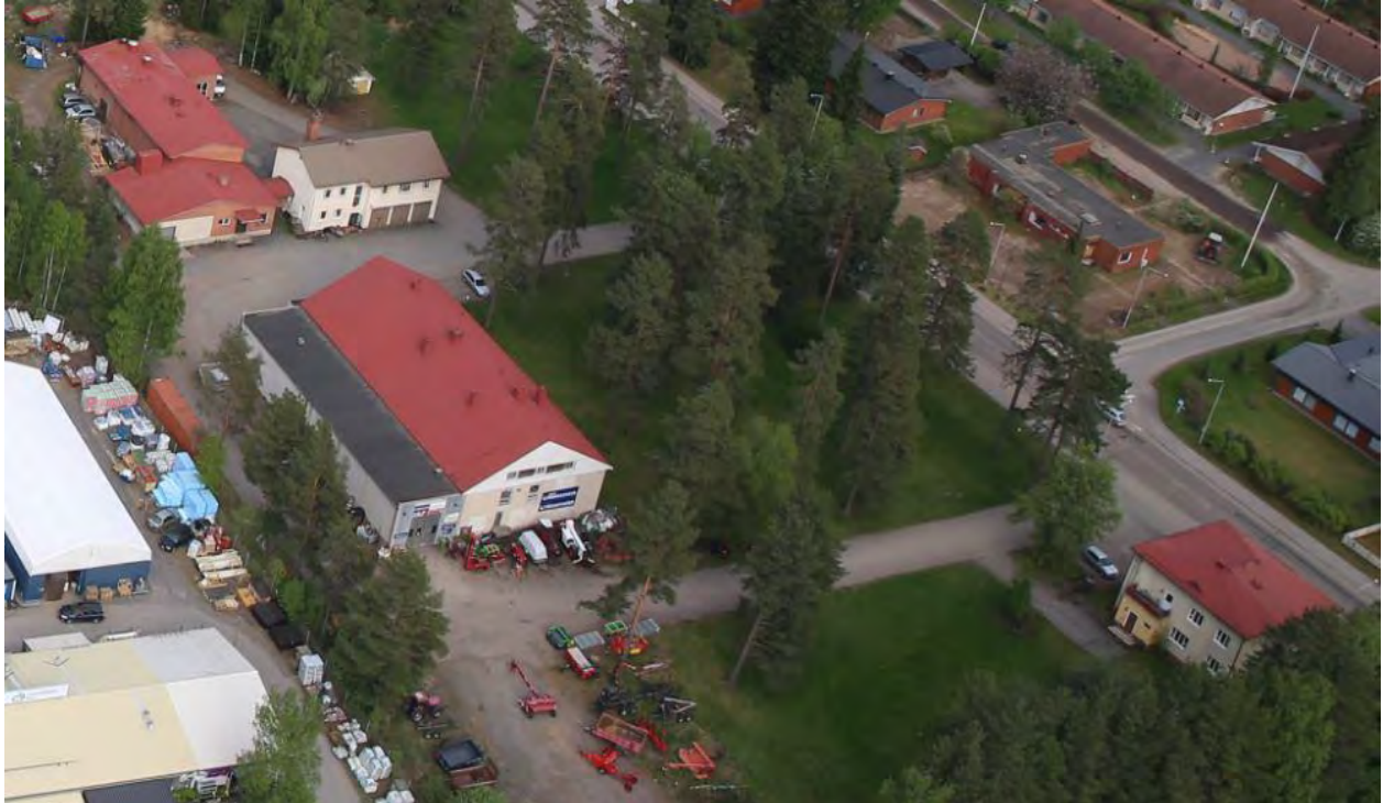
Kuva 13. Meijerin rakennukset ilmasta kuvattuna.
