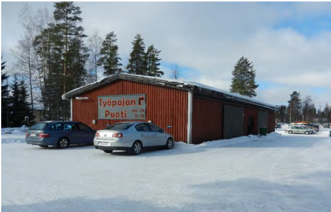
Kuva 12. Työpajarakennusta palveleva varastorakennus.
