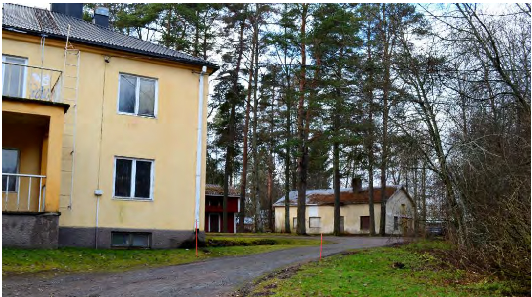
Näkymä pihapiiriin. Taustalla näkyy varastorakennus, mikä jää kaava-alueen ulkopuolelle.
