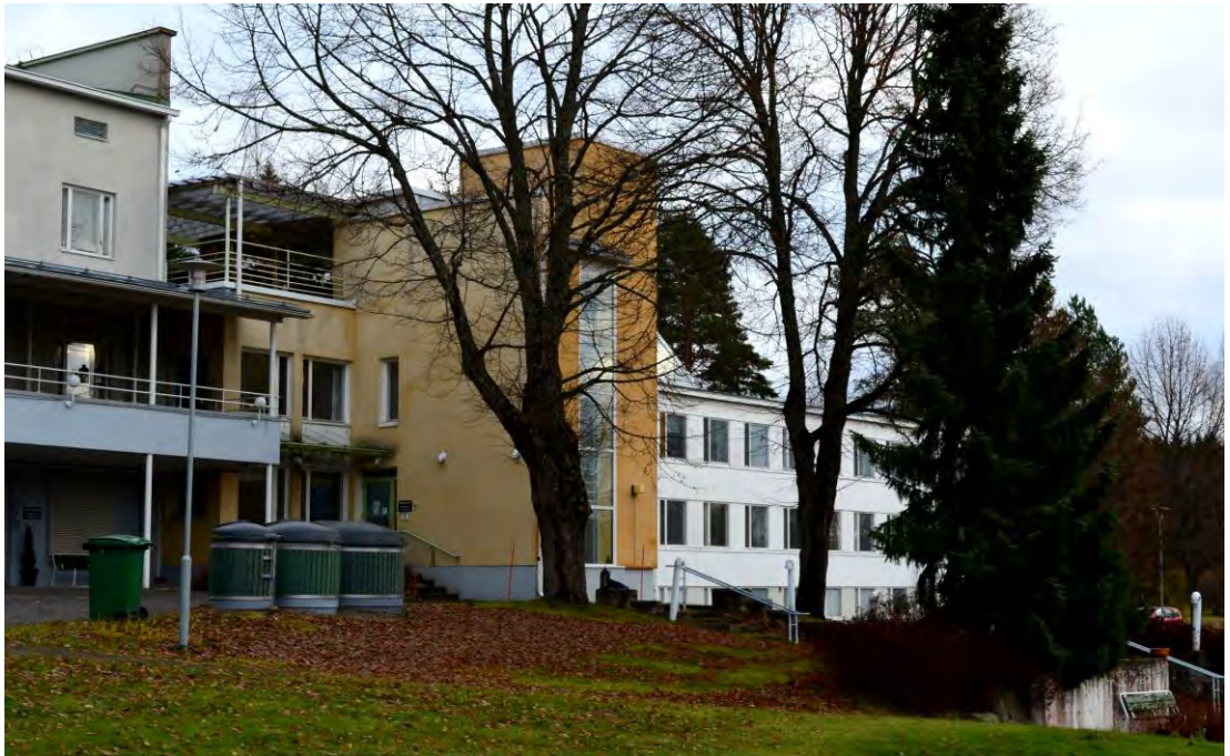
Rakennuksen keskiosa, missä 1990 luvulla rakentunut hissi.
