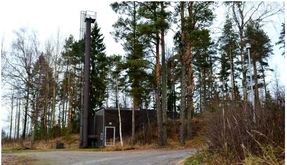
Rakennuksen pohjoispuolella oleva lämpökeskus.
