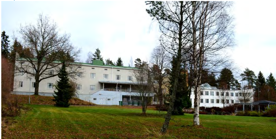
Näkymä rakennuksen suuntaan lännestä.
