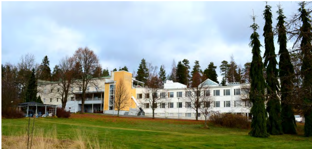
Näkymä rakennuksen suuntaan lännestä.
