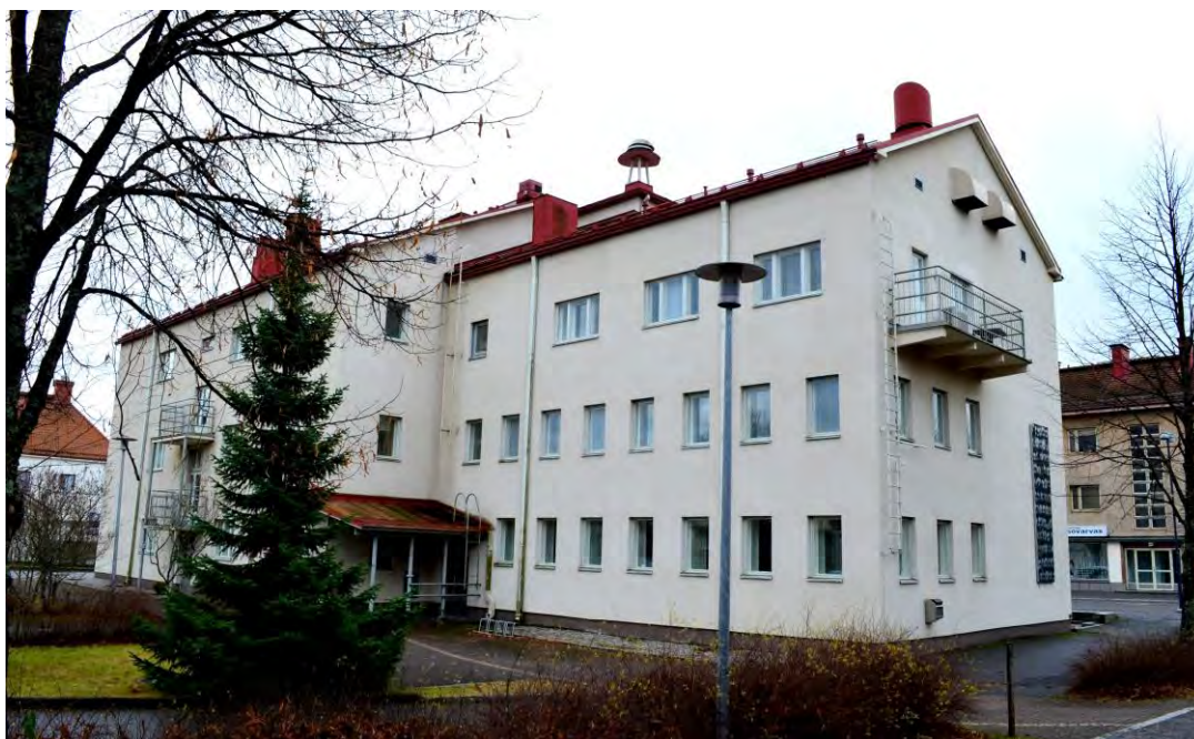
Näkymä takapihan puolelta
