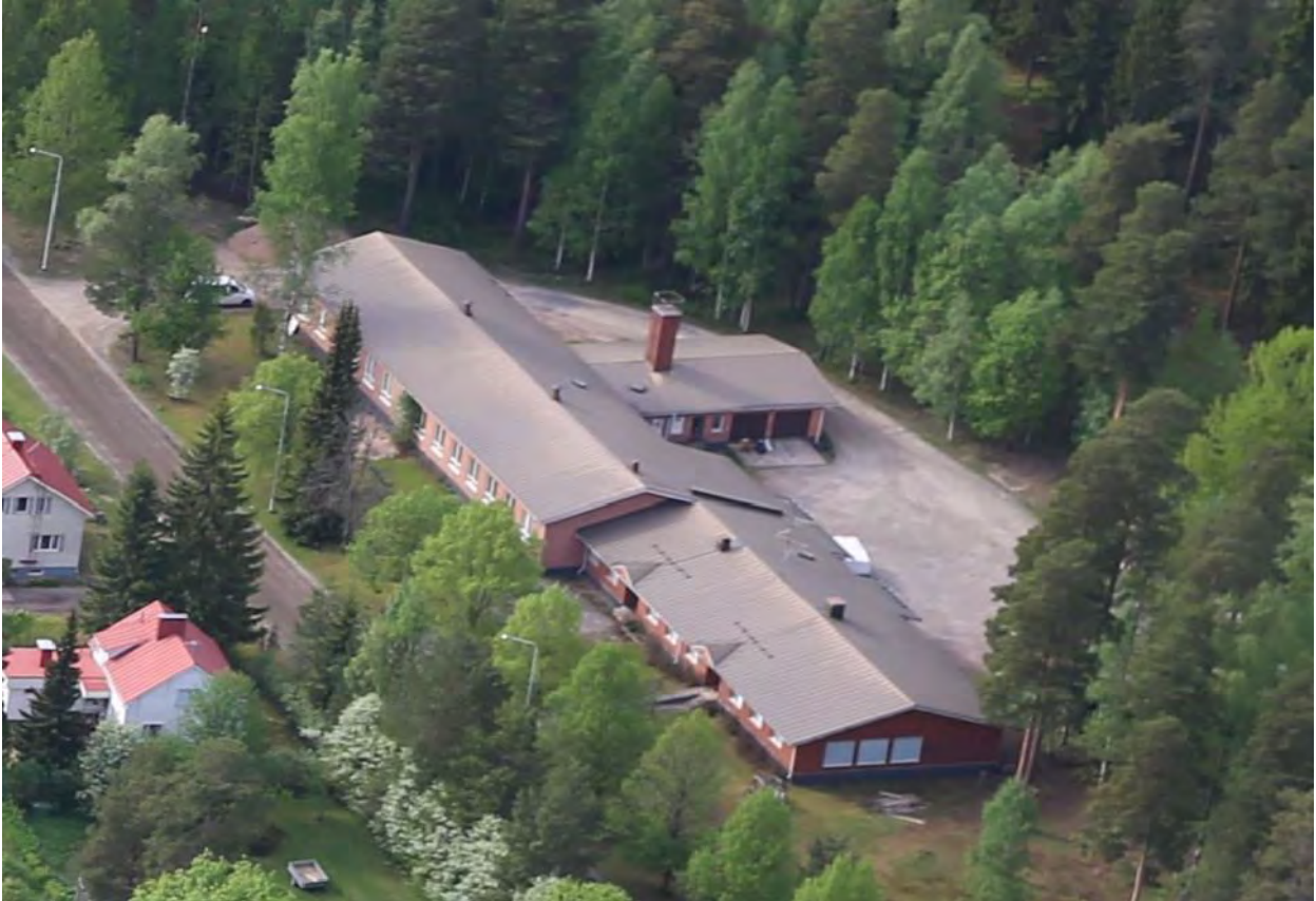
Kuva 12. Jyllin vanha kenkätehdas idän suunnalta kuvattuna. Kuvassa etualalla tehtaan asunto-osa. Röni-Kuva Oy 2018.
