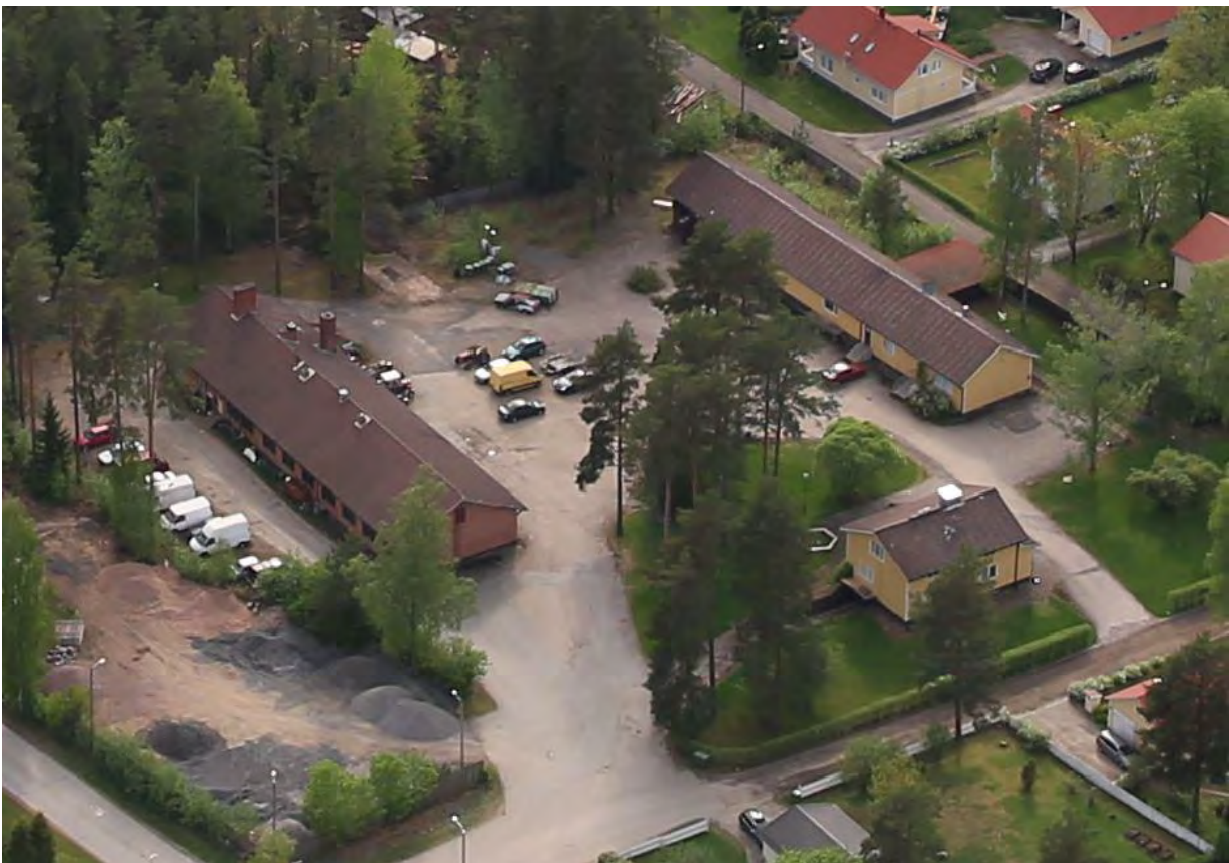
Kuva 11. Kaupungin omistama kiinteistö Knuutilankadun ja Sarvannontien kulmauksessa. Röni-Kuva Oy 2018.
