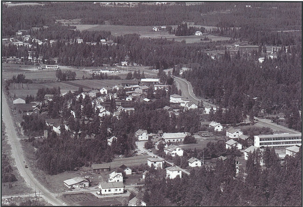
15. Näkymä keskustan pohjoisosaan. Laviantie on uusi, etualalla tasoliittymä Myllymäkeen, jonka rakentaminen oli alkamassa. Paikalla nyt alikulku.
