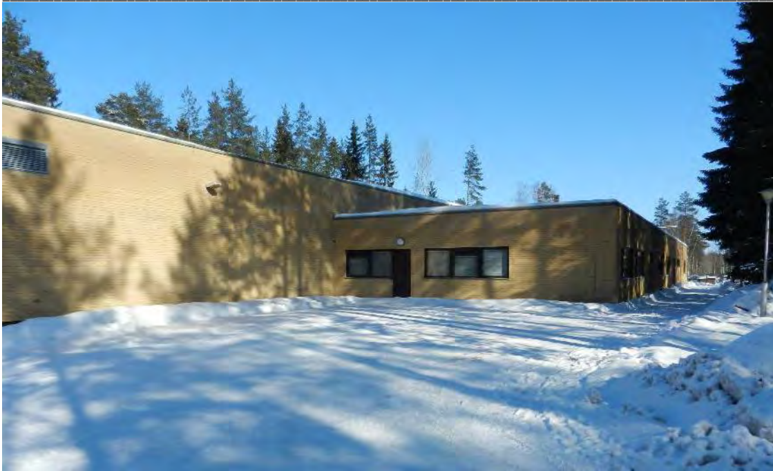
Kuva 20. Medipiste Oy:n jalkinevarasto/konttori pihasta kuvattuna.
