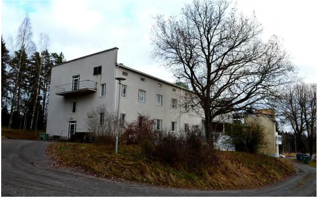
Kuva 7. Rakennuksen vanhin osa.
