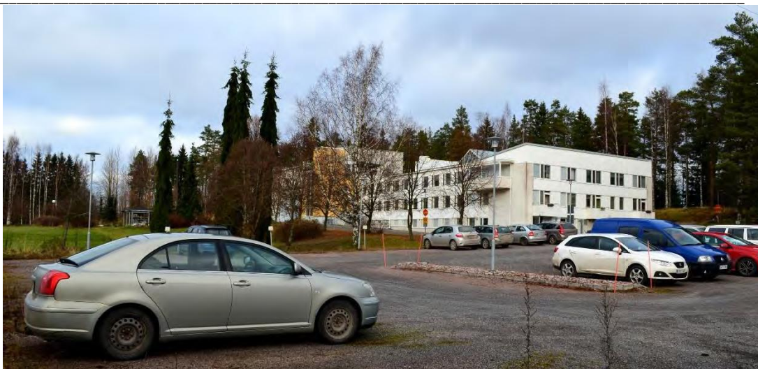
Kuva 4. Näkymä parkkipaikalta pohjoisen suuntaan.
