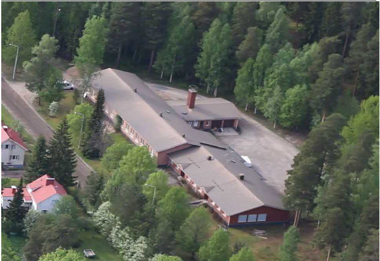
Kuva 11. Jyllin vanha kenkätehdas idän suunnalta kuvattuna. Kuvassa etualalla tehtaan asunto-osa. Röni-Kuva Oy 2018.
