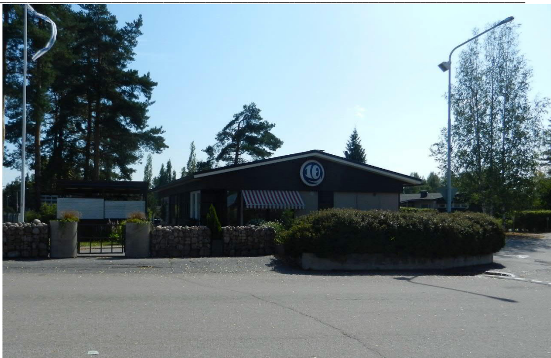
Kuva 6. Rakennus lännen suunnalta kuvattuna.
