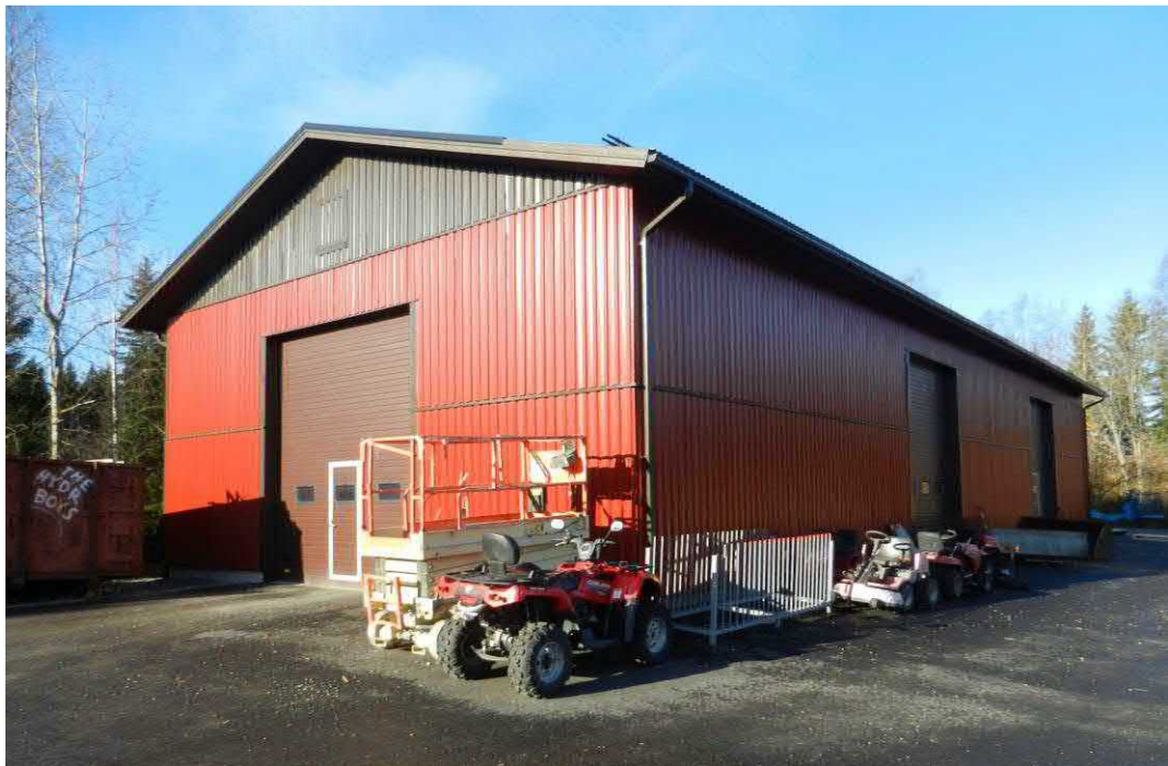
Kuva 9. Tontin pohjoisosassa sijaitseva vuonna 2018 valmistunut varastorakennus.
