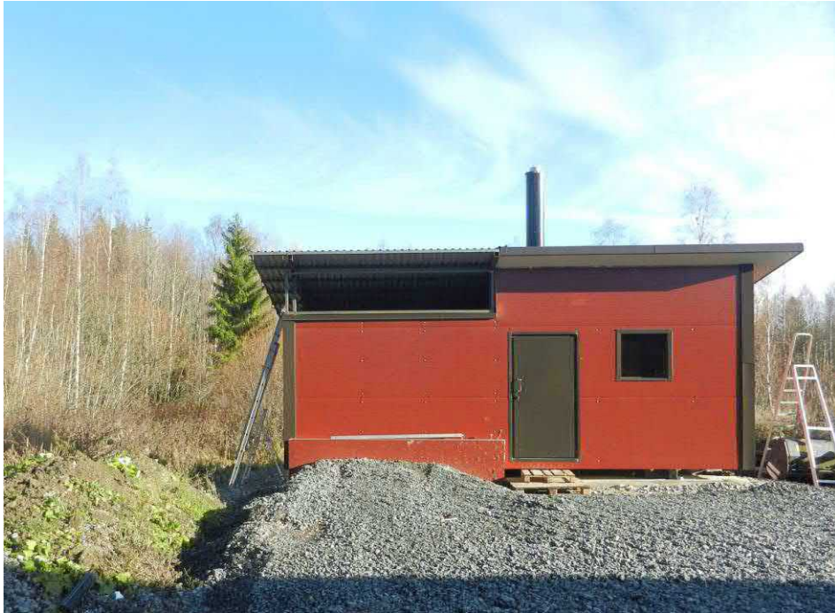
Kuva 10. Tontin koillisosassa sijaitseva uusi lämpölaitos.
