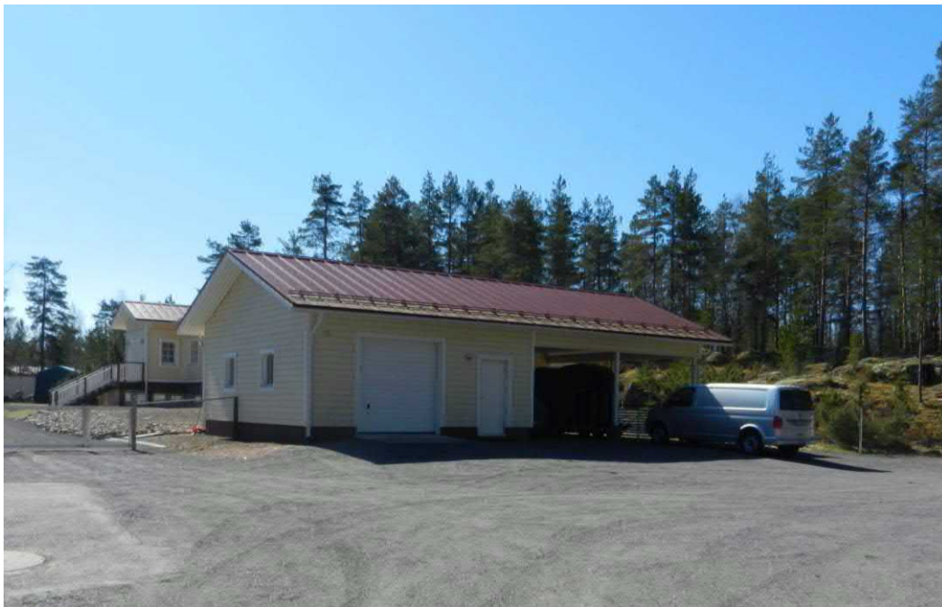
Kuva 8. Korttelissa 901 sijaitseva talousrakennus.
