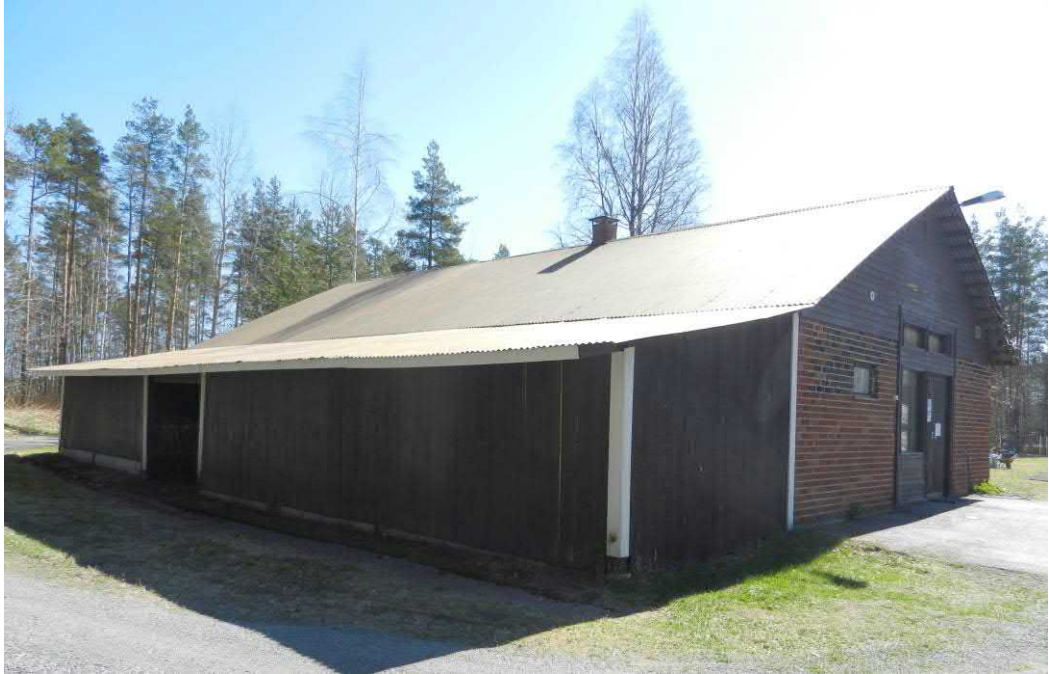
Kuva 6. Korttelissa 901 sijaitseva eläinlääkäriin vastaanottotilana toimiva rakennus.
