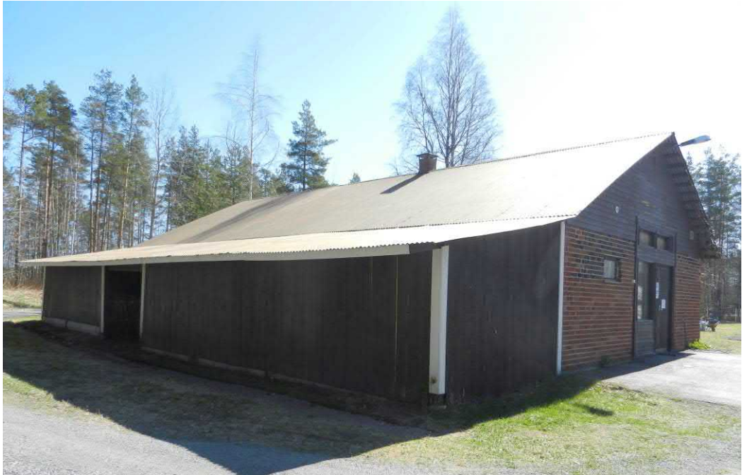
Kuva 7. Eläinlääkärin vastaanottotilana toimiva rakennus.
