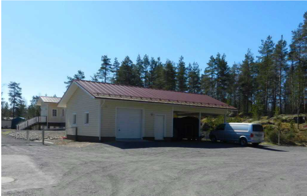
Kuva 9. Tontilla sijaitseva asuinrakennuksen talousrakennus.
