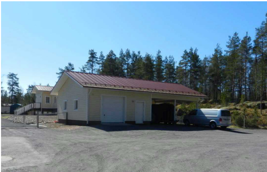
Kuva 8. Korttelissa 901 sijaitseva talousrakennus.
