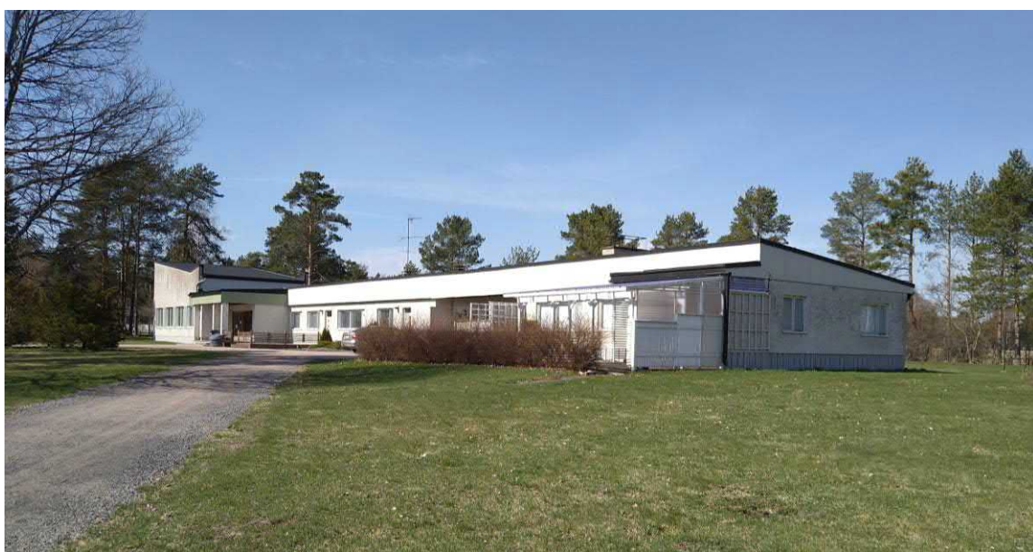
Kuvat 9 ja 10. Niinisalon seurakunta/kirkkorakennus.
