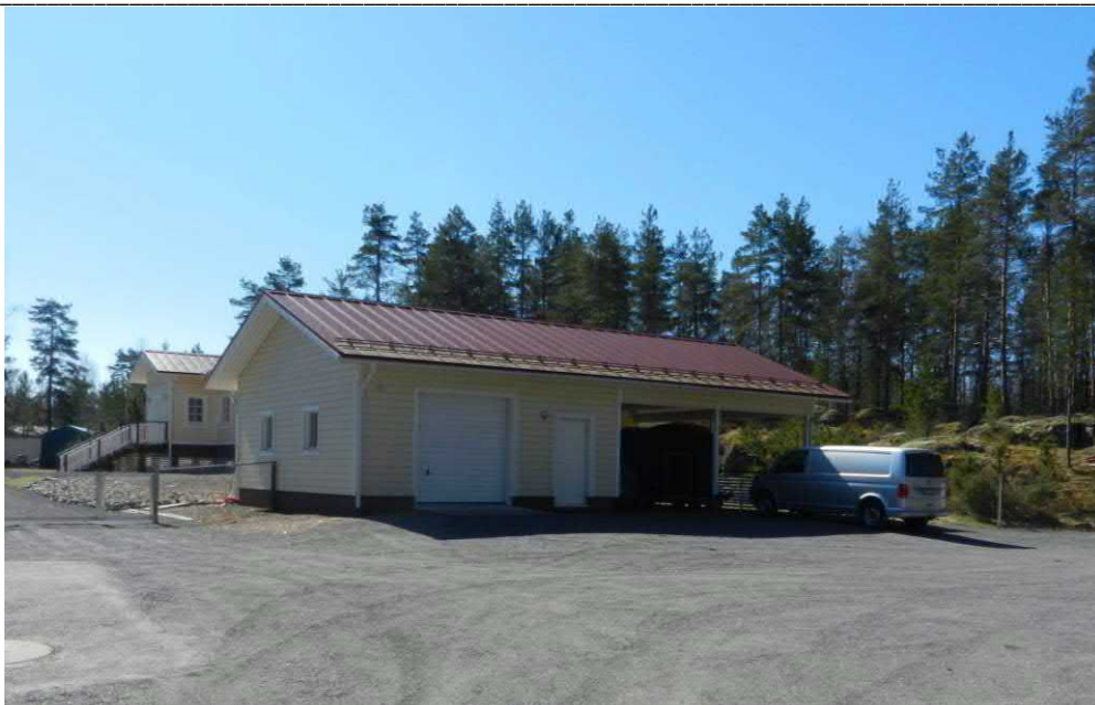
Kuva 9. Tontilla sijaitseva asuinrakennuksen talousrakennus.
