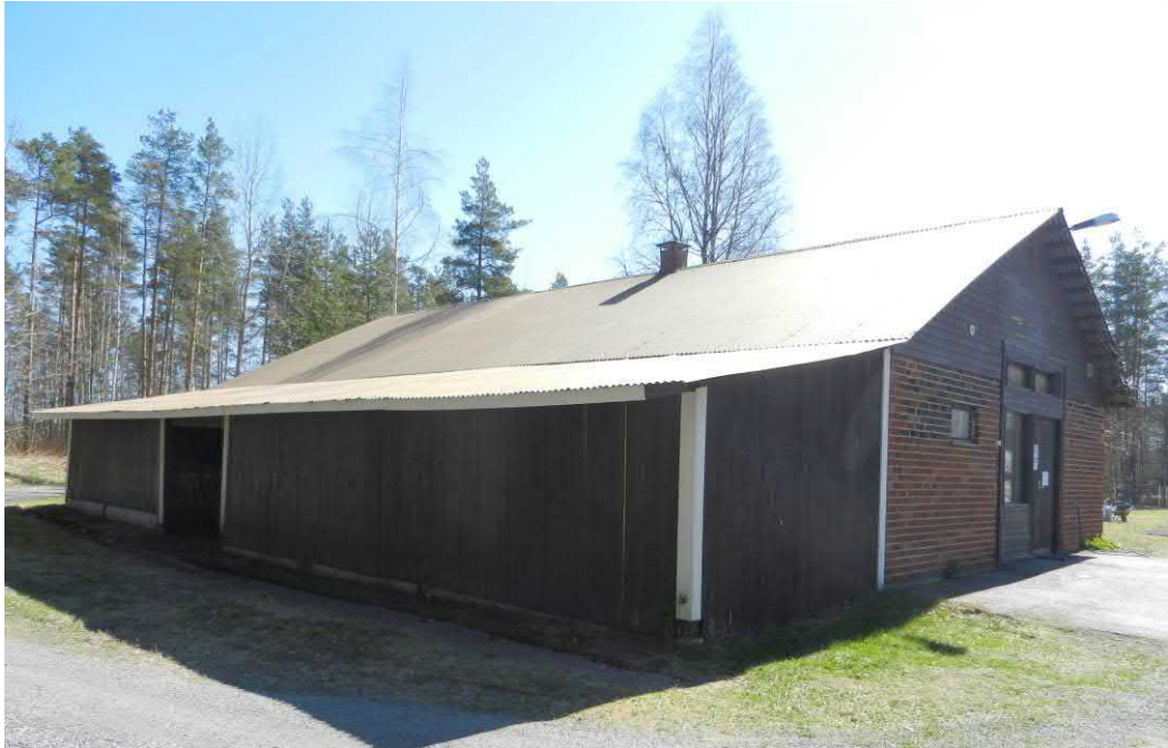
Kuva 7. Eläinlääkärin vastaanottotilana toimiva rakennus.
