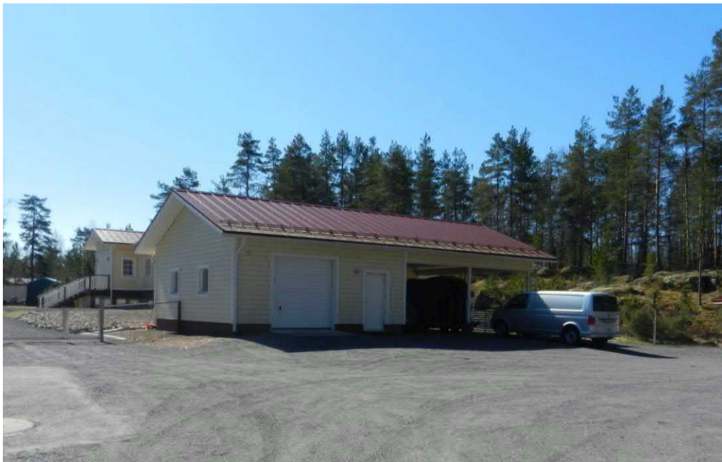
Kuva 8. Korttelissa 901 sijaitseva talousrakennus.
