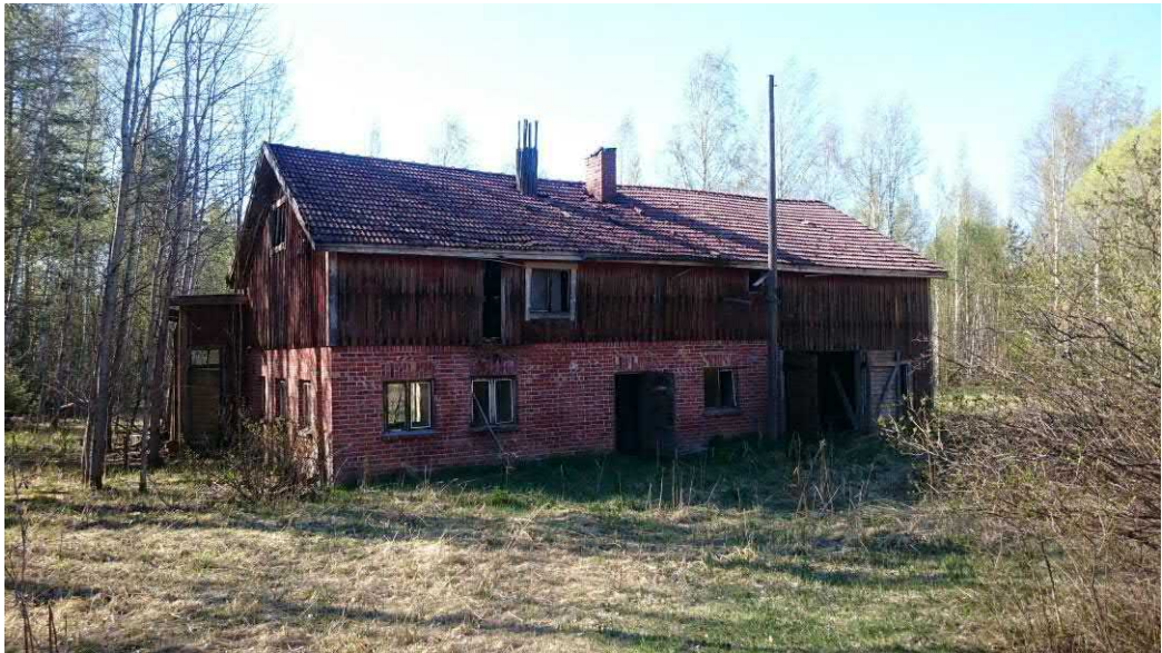
Kuvat 10 ja 11. Vanhan asuinrakennuksen talousrakennuksia.
