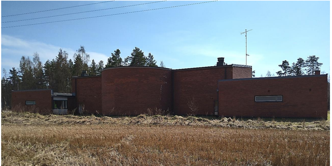
Kuva 8. Niinisalon koulu pohjoisen suunnalta kuvattuna.
