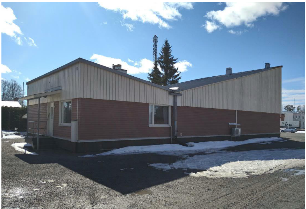
Kuva 5. Kankaanpään helluntaikirkko takaviistosta kuvattuna.
