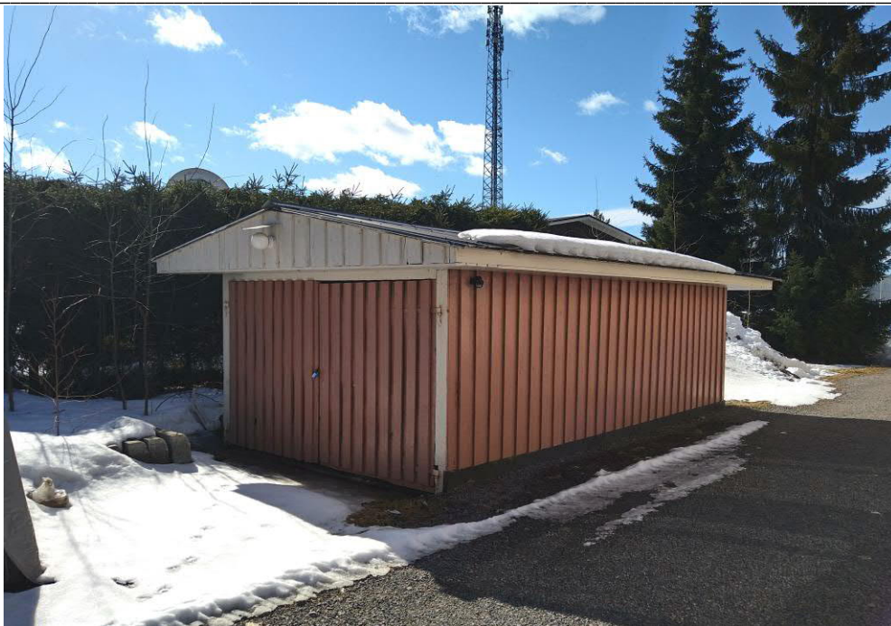
Kuva 6. Helluntaikirkon vieressä sijaitseva pieni autotalli/varasto, joka puretaan kirkon laajennusosan alta
