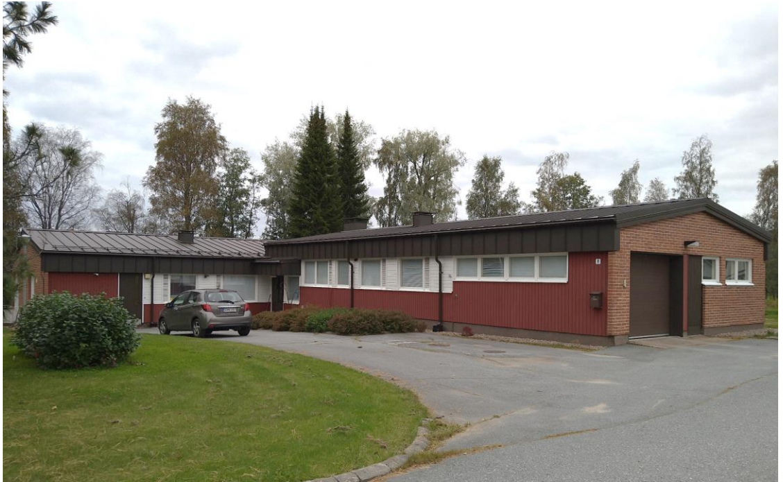
Kuva 6. Entinen eläinlääkärintalo kaakon suunnalta kuvattuna.
