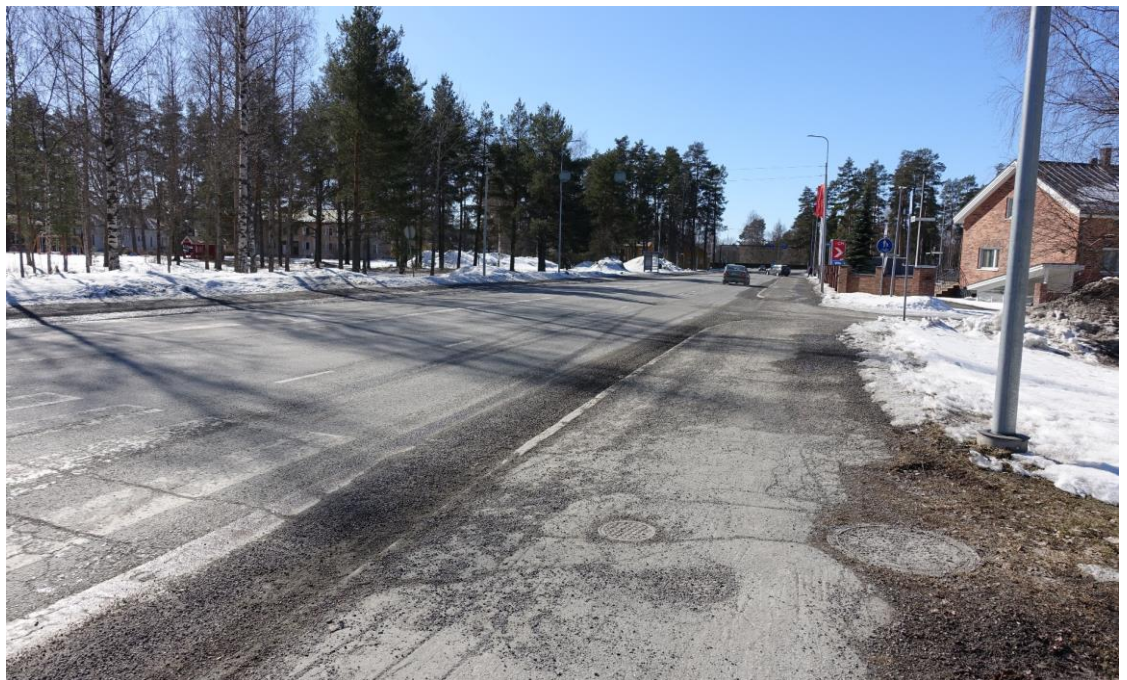
Kuva 9. Jämintietä koillisen suunnalta kuvattuna.
