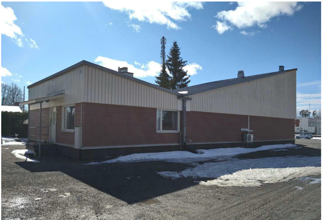
Kuva 5. Kankaanpään helluntaikirkko takaviistosta kuvattuna.
