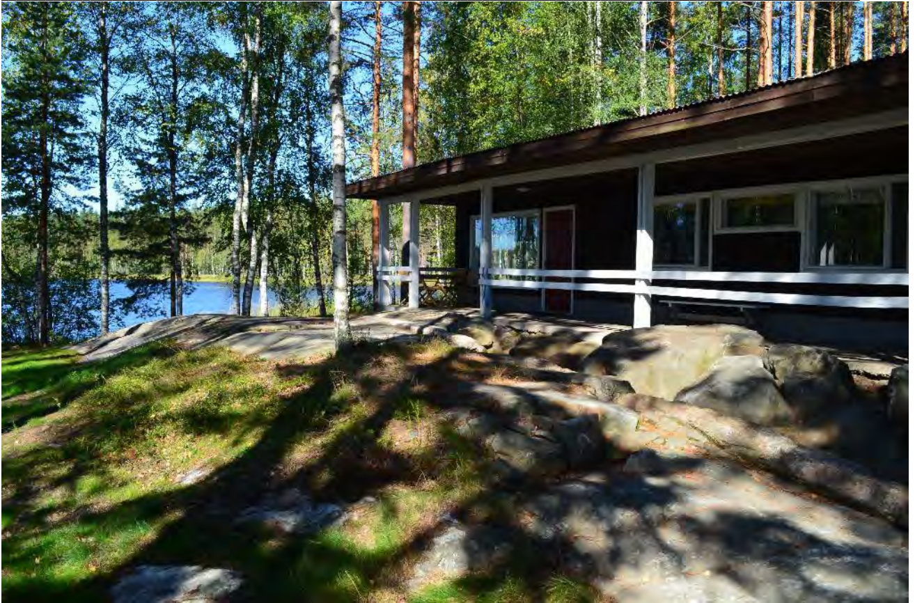
Kuva 3. Tilalle Liisanniemi rakennettu lomarakennus
